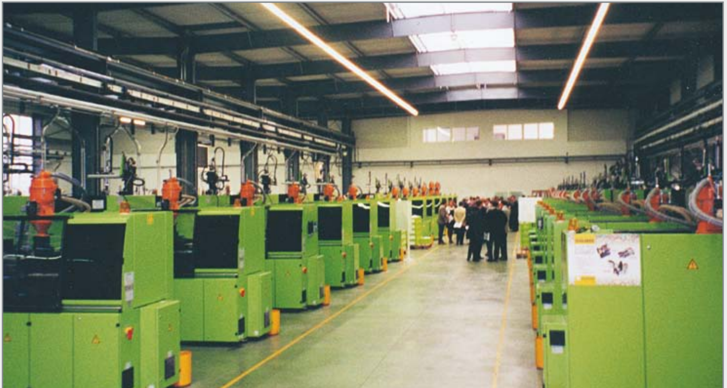
Zentrale Granulatversorgung für 90 Verarbeitungsmaschinen
