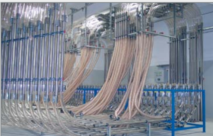
Hier wird extrem hartes Material an 60 Verarbeitungsmaschinen verteilt
